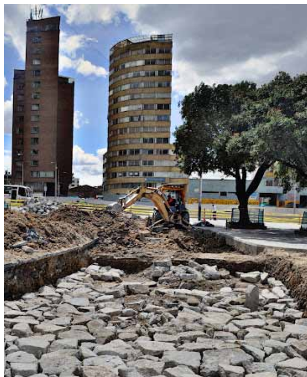
Bogotá, Colombia. Excavación para mejora de las vías públicas. © Víctor Alfonso González
